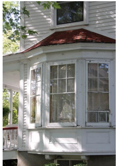
Fenêtre à guillotine à petits-bois 518, boulevard Marie-Victorin
