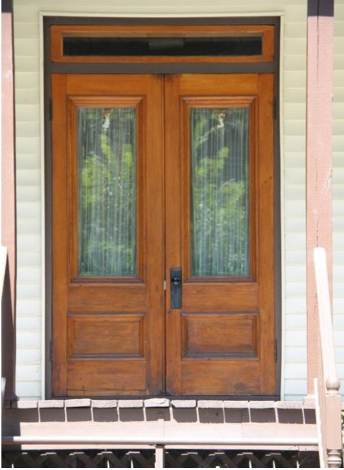
Porte à doubles battants 22, boulevard De Montarville
