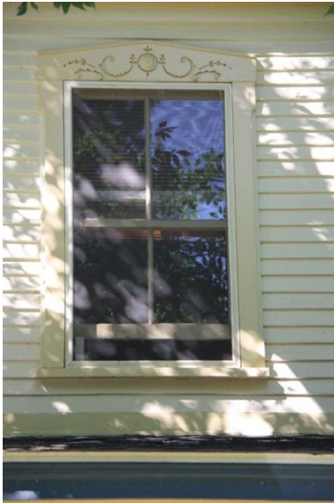
Fenêtre à guillotine à petits-bois 17, rue Guérin
