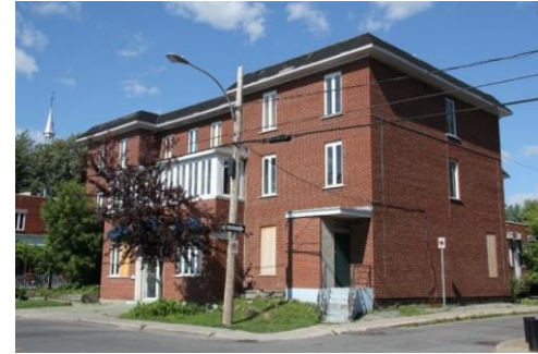
Exemple d'architecture commerciale 536, boulevard Marie-Victorin
