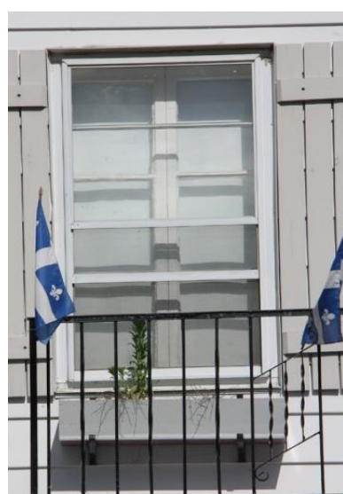
Fenêtre à battants à grands carreaux (la contrefenêtre métallique est surtout visible ici) 562, rue Saint-Charles
