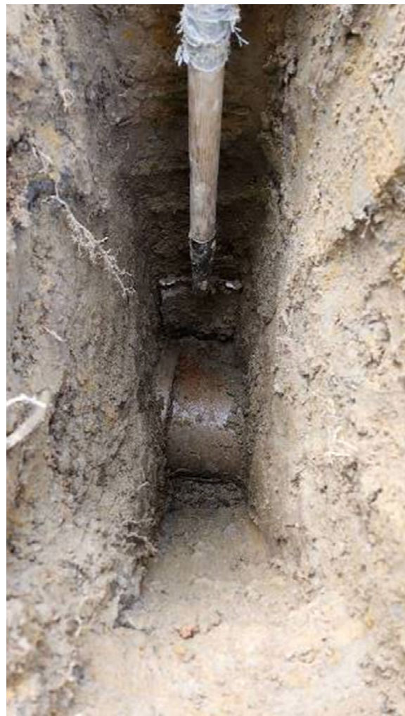
Photo 42. Tuyau d'égout 7A2, vue en plan vers l'est (vestige 64; BFi-24-22-NUM1-49)
