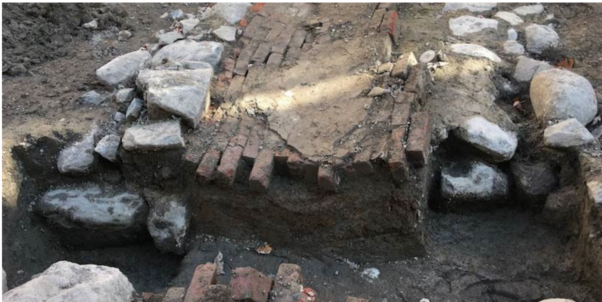
Photo 32. Caniveau en briques et paroi est de du sondage 10V, vue vers l'est (BjFi-24-22-NUM2-101)
